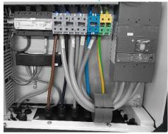
FIGURE 30: CONNECTING THE AC POWER CABLE
